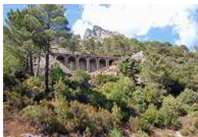
Viadukt der Schmalspurbahn
